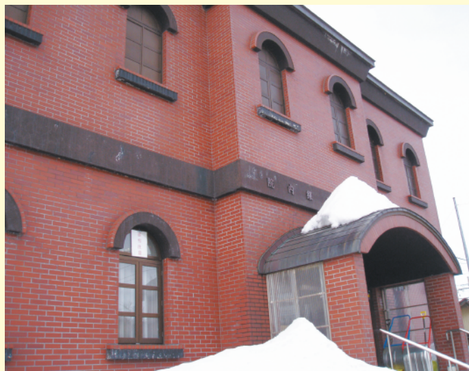
JR院内駅が併設された現代風の異人館
