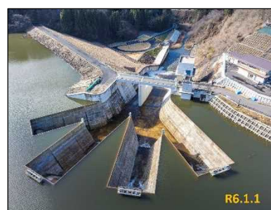
試験湛水状況
