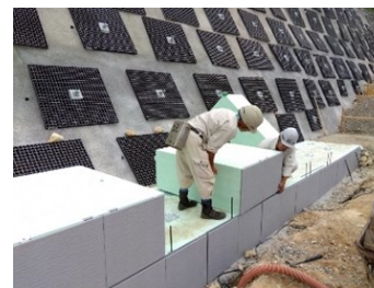
発泡スチロールを用いた超軽量盛土工
