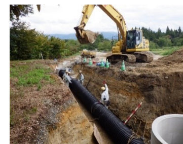
排水構造物工（暗渠排水管）
