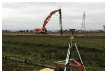
中層混合処理工（ICT）
