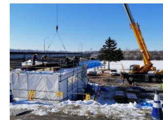
雪寒仮囲い工
