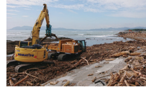
延岡港海岸 令和4年台風14号による漂着物撤去 (写真提供：一般社団法人宮崎県建設業協会)
