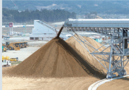
陸前高田市震災復興事業におけるベルトコンベヤによる土砂搬送 (写真提供：清水建設株式会社)
