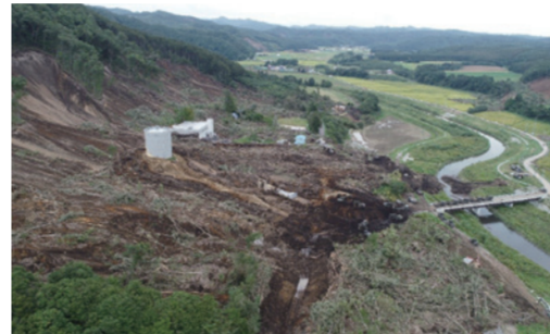
北海道胆振東部地震では、厚真町を中心とした広い範囲で土砂崩れが発生した (写真提供：一般社団法人北海道建設業協会)
