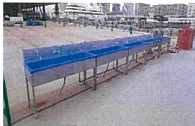
現場の手洗い場所の増設
